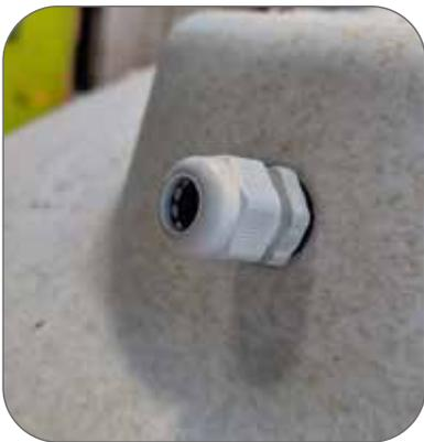
2. Führen Sie ein Kabel mit einem Außendurchmesser von ca. 10 mm durch die Verschraubung und ziehen Sie es in die Mitte des Kellers. Ziehen Sie die Verschraubungsmutter fest, um das Kabel zu blockieren und die Verbindung abzudichten.
