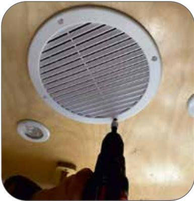
1. Schrauben Sie das Lüftungsgitter ab und suchen Sie das Kabel mit dem Anschlussstecker.
